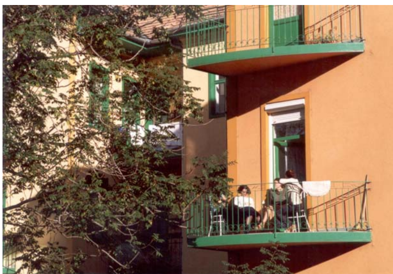
Felújított lakóépület egy forgalom-mentes tömbbelsőben
