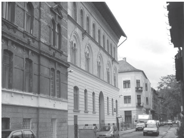
3. kép Felújított önkormányzati lakóépület a Középső-Józsefvárosban (Nap utca)
