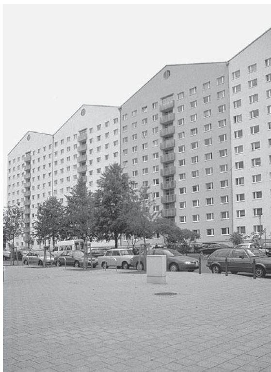
2. kép Tetőtér-beépítés magastető kialakításával
