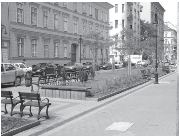
2. kép A Tompa utca felújítás után
