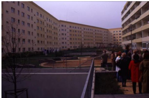
18. fotó A lakások és a belső udvarok kapcsolatának megteremtése feljáró hozzáépítésével (a lépcső egyúttal a mélygarázsok megközelítésére is szolgál)
