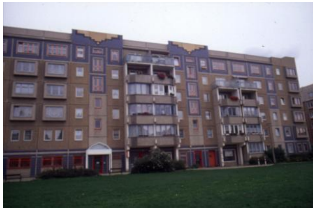
9. fotó A homlokzat átalakítása színezéssel és plasztikával
