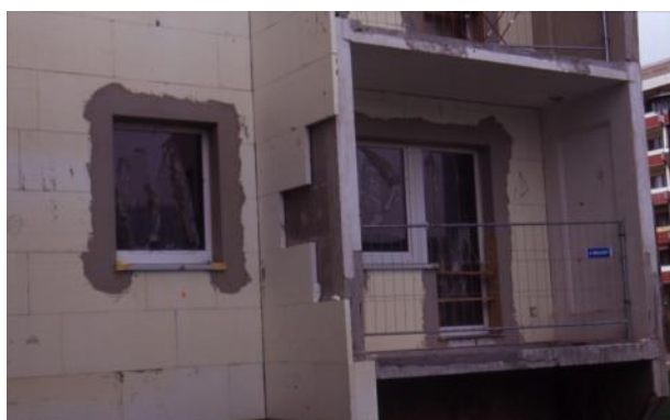
3. fotó Panelépület küls h szigetelése és a nyílászárók cseréje a rehabilitációs program keretében
