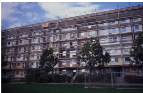
2. fotó Lakótelepi épület homlokzatának felújítása
