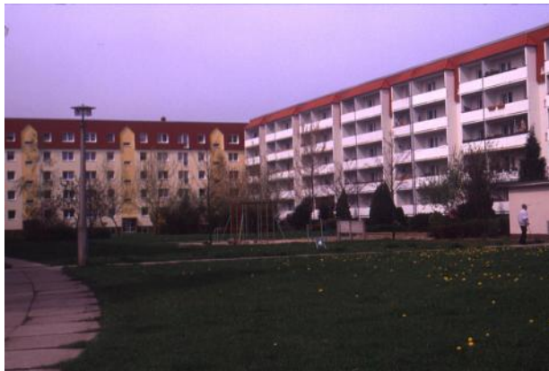
11. fotó Magastet imitálása lapostet vel rendelkező lakóépületeken
