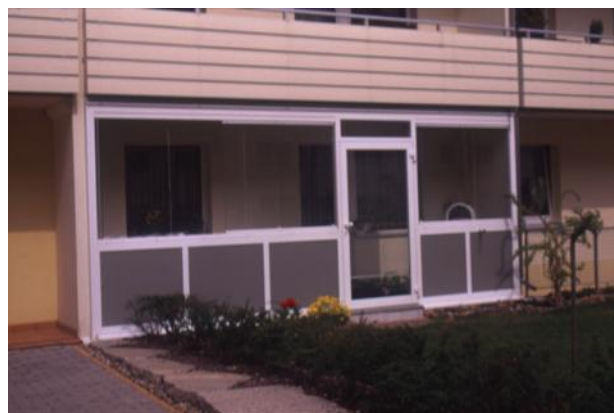
10. fotó Az erkély beüvegezése és új lakásbejárat kialakítása a belső udvar felől
